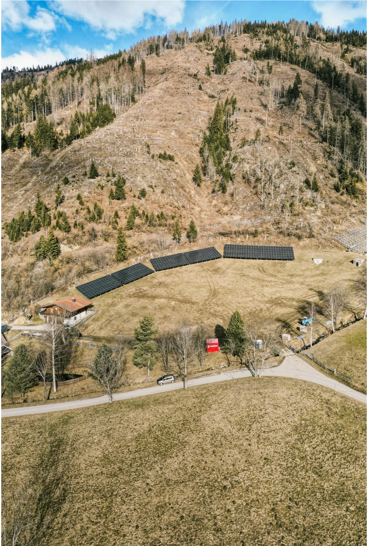
1.200 Paneele werden auf 150 Laufmetern und einer Fläche von 3.000 Quadratmetern
